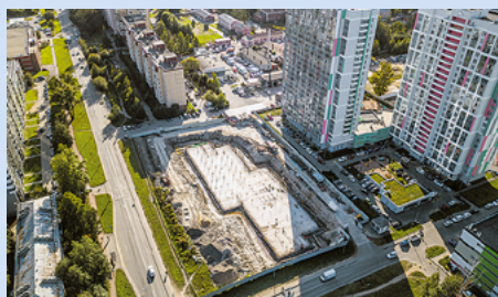
Строительство взрослой поликлиники
