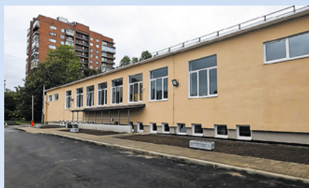
Новая станция скорой помощи на Учительской улице
