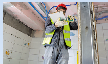
Ход капитального ремонта поликлиники № 118
